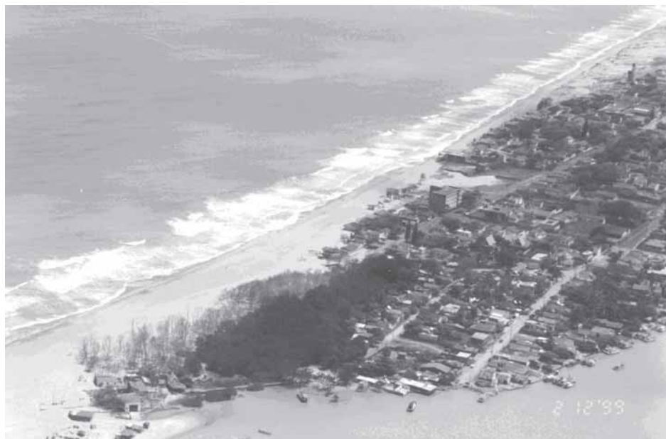
Figura 11. Erosão em Atafona desembocadura do rio Paraíba do Sul – RJ
